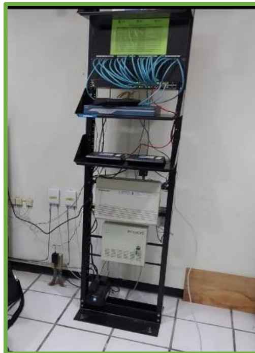
Instalación Infinitum síncrono planteles Conalep
