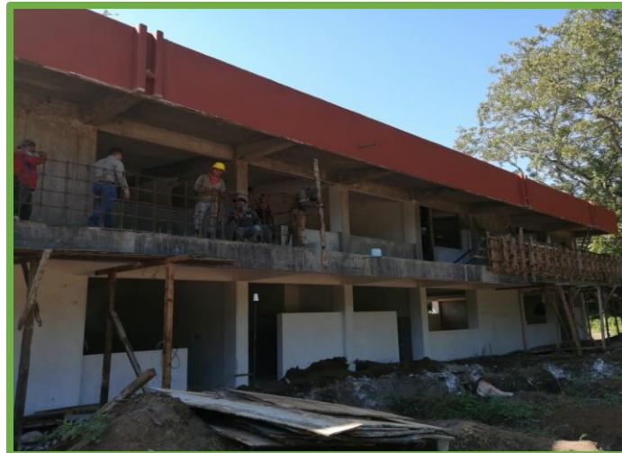
Aspecto de la construcción del Plantel 337 Álamo
