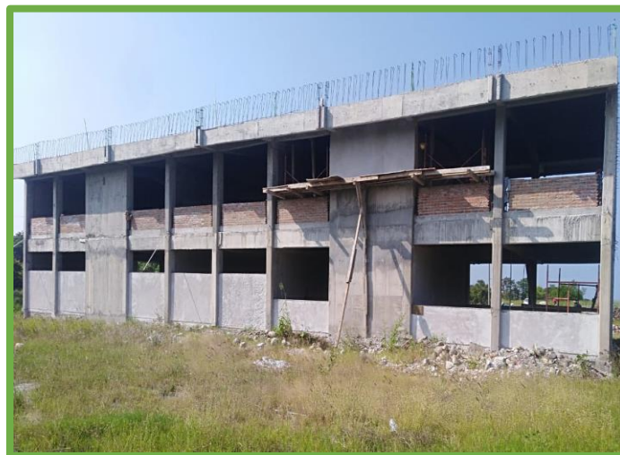
Aspecto de la construcción del Plantel 320 Vega de Alatorre
