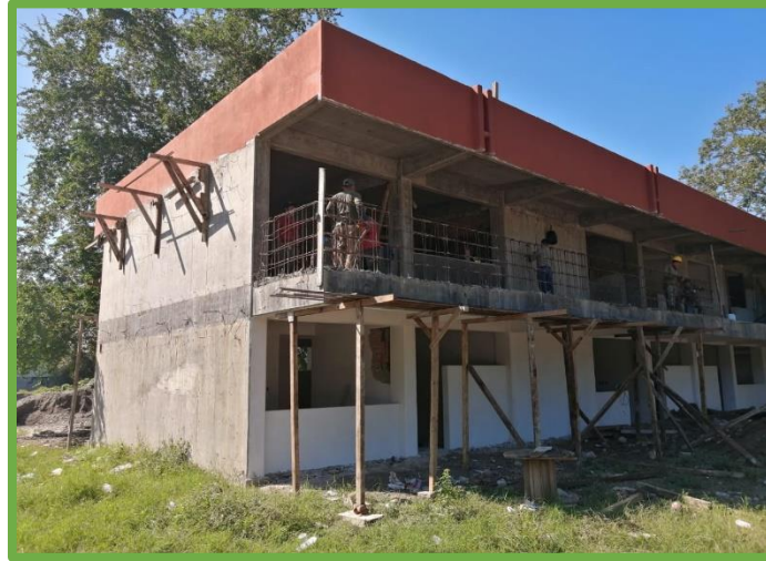
Aspecto de la construcción del Plantel 337 Álamo
