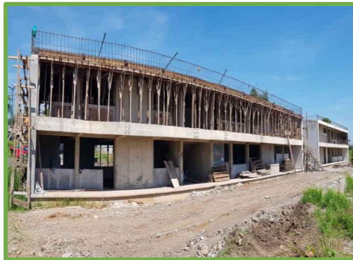
Aspecto de la construcción del Plantel 338 Córdoba
