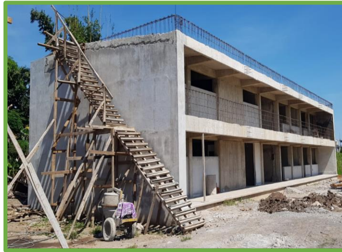
Aspecto de la construcción del Plantel 338 Córdoba
