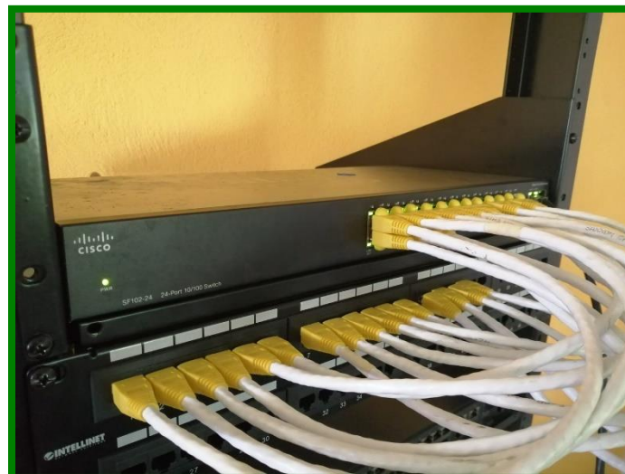
“Aspecto de instalación de cableado”
