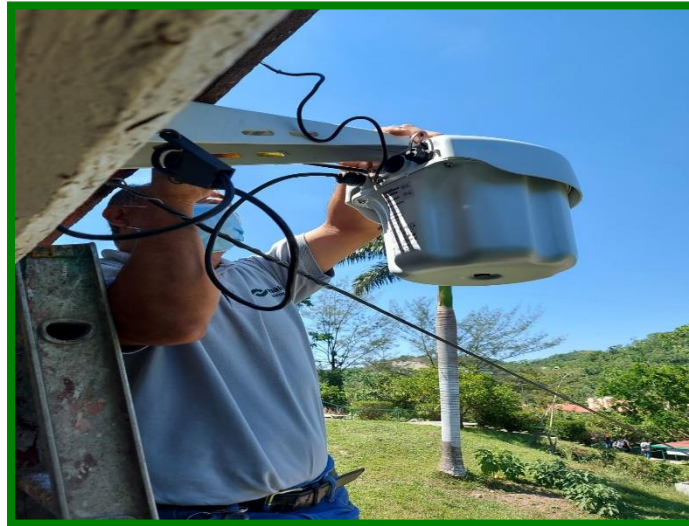
“Aspecto de instalación de cableado”
