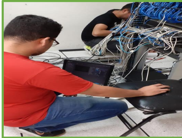
“Mantenimiento de equipo del SITE de la Dirección General”
